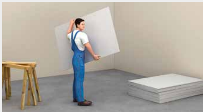
Posamezne fermacell® plošče nosimo v pokončni legi
