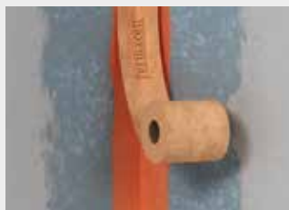
Slika 2+3: fermacell™ tesnilni trak vtisne- mo v predhodno nanešeno tekočo folijo in še enkrat premažemo s tekočo folijo – sušenje tekoče folije najmanj 1 uro
