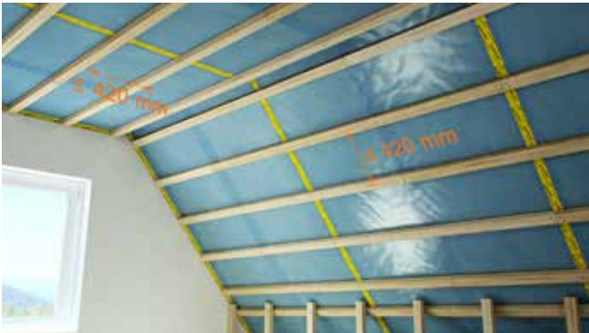
Oсни razmaki na podkonstrukciji pri stropih in poševninah
