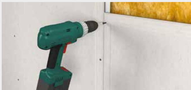
Vijačenje na kovinsko podkonstrukcijo
