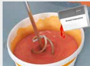
Slika 7: 2. nanos: v preostanek tekoče folije dodamo barvni koncentrat in ga homogeno zmešamo da obarva celotno maso. Potem na debelo nanesemo obarvano tekočo folijo z valjčkom. Več informacij najdete v tehničnem listu. Priporočamo, da drugi nanos nanašate prečno na smer nanašanja prvega nanosa. Tako se izognemo morebitnim šibkim mestom.
