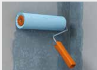
Slika 1: nanašanje fermacell™ predpre-mazov – sušenje najmanj. 2 uri – mešalno razmerje: 1:1 do 1:2 z vodo
