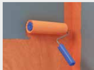
Slika 6: Izvedba zatesnitve za razreda učinkovanja vode W1-I in W2-I. fermacell™ tekočo folijo naneseemo z valjčkom (2 x po celi površini). Sloj posušenega premaza naj znaša vsaj 0,5mm. V skladu z normo DIN 18534-3 je potrebno drugi nanos zaradi boljše sledljivosti nanesti v drugi niansi
