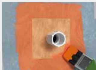
Slika 4: za zatesnitev instalcijskih prebojev uporabimo fermacell™ tesnilno manšeto vtisnemo v tekočo folijo, ki je še mehka in še enkrat premažemo s tekočo folijo – sušenje tekoče folije najmanj 1 uro
