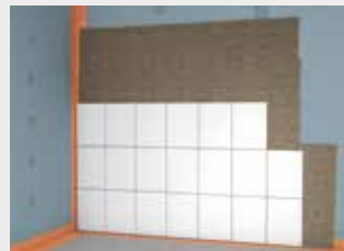
Slika 5: zaščita zatesnitve za razred učinkovanja vode W0-I. Oblaganje s keramiko s pomočjo lepila fermacell™ Flexkleber v tankoslojnem postopku
