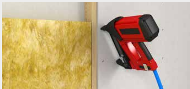
Pritrdjevanje s sponkami na leseno podkonstrukcijo
