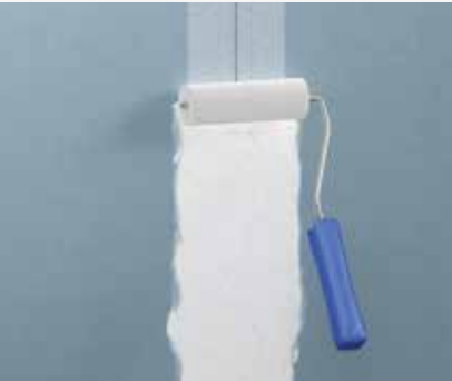
Armirni trak premažemo s tekočim lepilom
