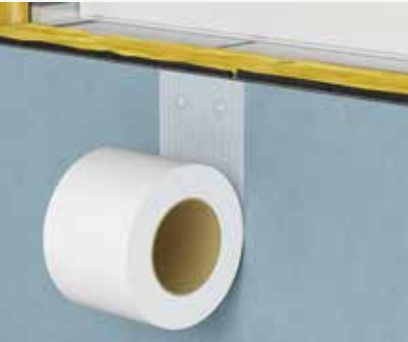
Preplepljenje stikov s fermacell™ Powerpanel armirnim trakom
