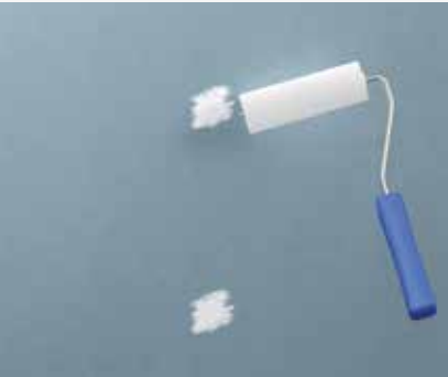
Pokrivanje glav pritrdilnih elementov s fermacell™ Armierungskleber HD
