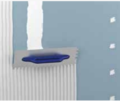
Nanašanje fermacell™ lahke malte HD v debelini 5–6mm kot osnovni omet
